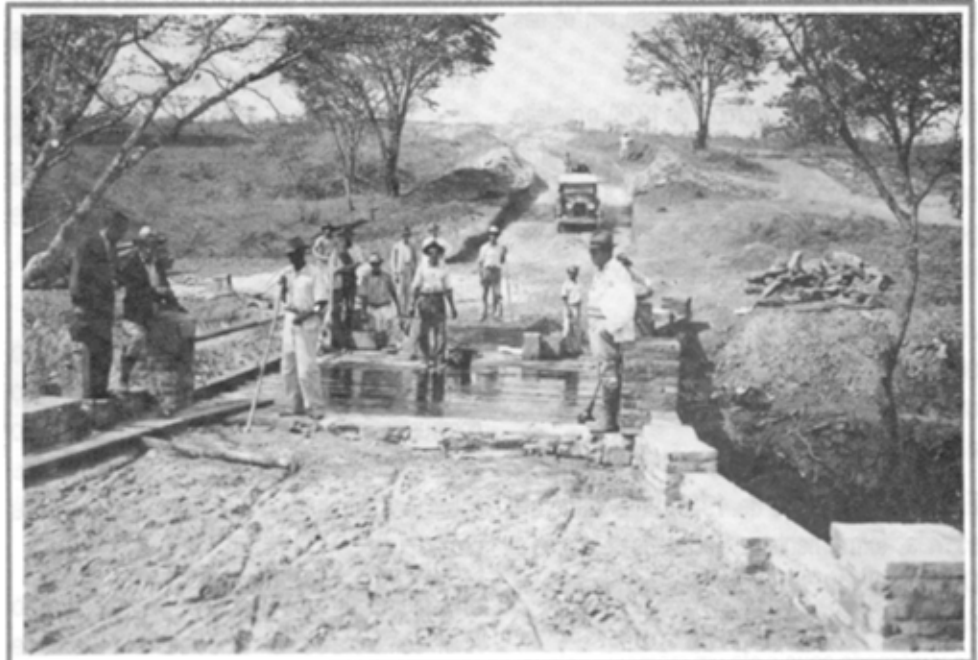
O prefeito Fausto Alvim visita as obras de construção da ponte sobre o Rio Tamanduá, na Rodovia Valadares - Araxá/Catiara. A intensa integração entre os poderes municipal e estadual permitiu a abertura de acessos graças à política do Governo Vargas. 1939. Fotografia de Octávio Fonseca. SPH/FCCB/AF/00114
